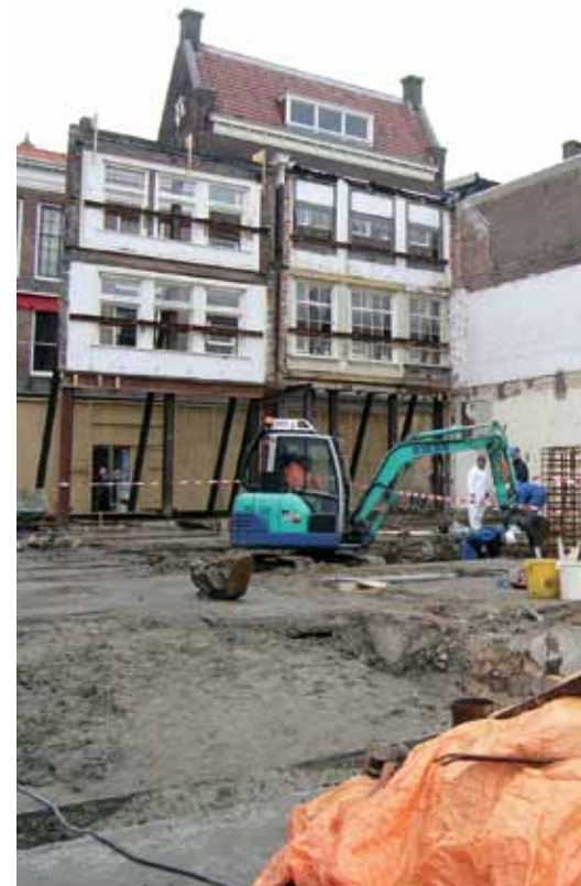
De bouwput aan de Langestraat na de sloop met de nog overeind staande oostelijke zijmuur en voorgevels.
