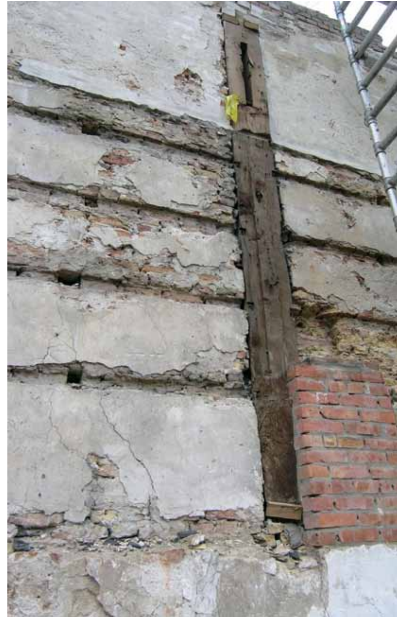
De oostelijke zijmuur van Langestraat 73. We zien de muurstijl en andere bouwsporen uit de tweede helft van de 16de of vroege 17de eeuw.
