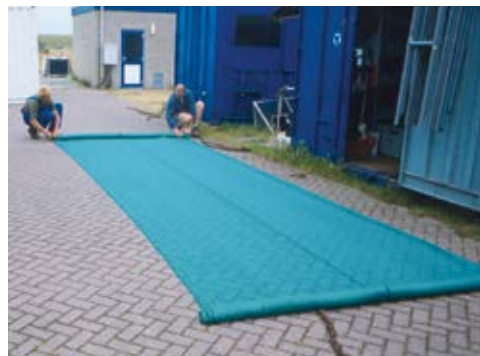
Afb. 5.2 Preparatie van de steigergazen: het steigergaas wordt op lengte afgesneden en aan de uiteinden wordt een ketting ingenaaid.
