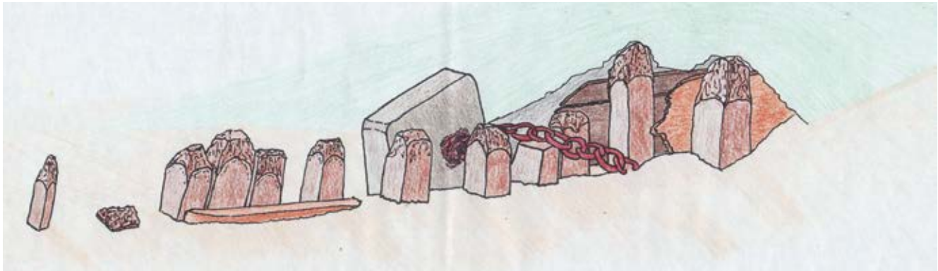
Afb. 8.9 Impressie van een stuk boordconstructie met kattesporen. De tekening geeft een goede indruk hoezeer al het hout aan de bovenkant is aangevreten door de paalworm. De grote steen hoort niet bij het wrak, maar is de ankersteen van oude betonning.
