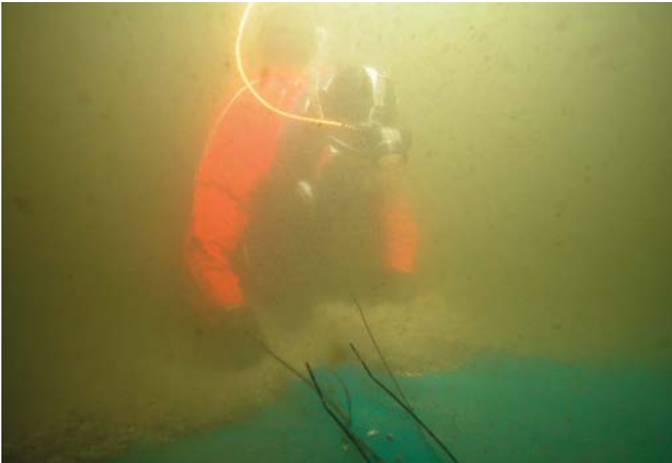
Afb. 5.4 De steigerzaken zijn over het wrak uitgerold en met tie-wraps aan elkaar genaaid.
