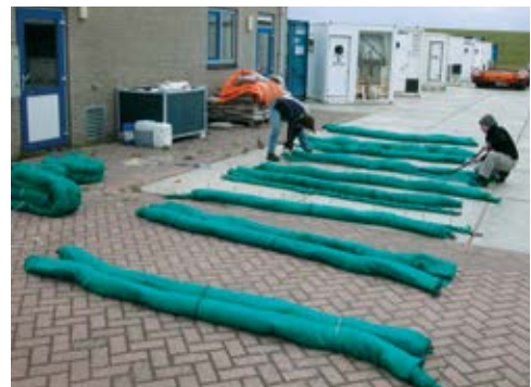
Afb. 5.3 Preparatie van de steigergazen: de steigergazen worden opgerold en klaargemaakt voor transport.
