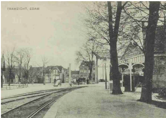
Noordelijk aanzicht van de trambrug, ter hoogte van de huidige Singelweg-Zuidervesting. In het begin van de vorige eeuw is de gracht gedempt en is de trambaan erover aangelegd.
