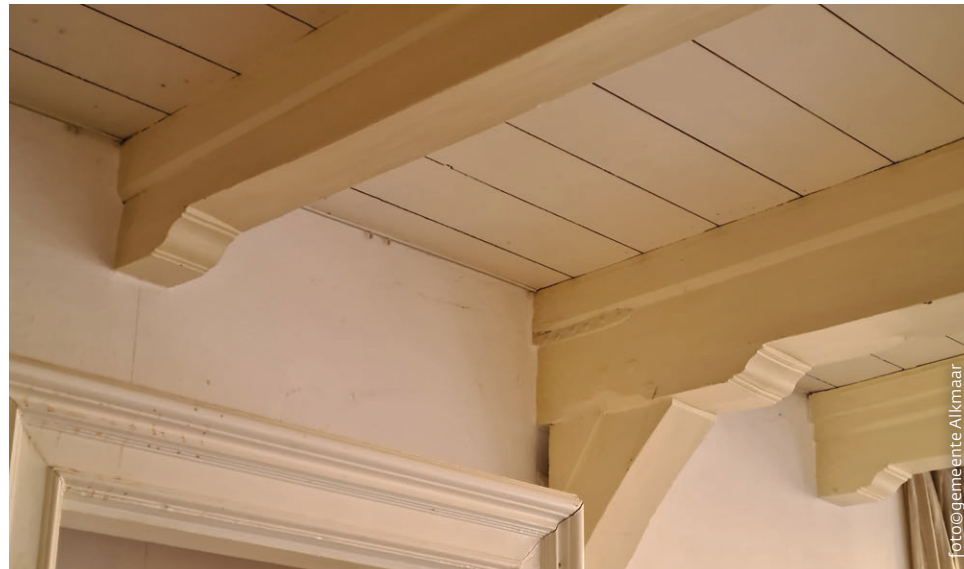
Authentieke delen van het houtskelet met consoles en sleutelstukken in renaissancestijl, eind 16de of begin 17de eeuw, nog aanwezig aan de zuidkant bij de vorste drie balkvakken.
