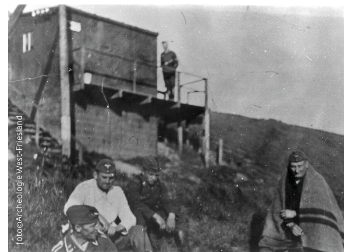
De FluWa op de dijk bij Warder.
