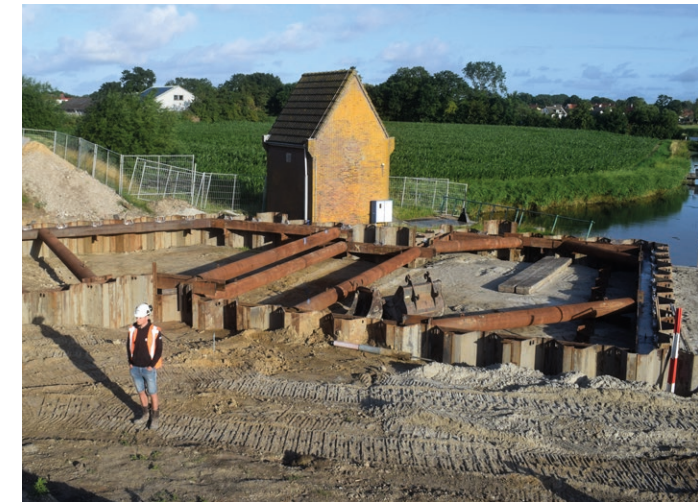
Op de voorgrond de bouwkuij voor het nieuwe gemaal, in het midden het markante gebouw van het huidige gemaal De Hoelm, rechts de kruin van de Hoelmerdijk. De kijkrichting is west, richting De Haukes.
