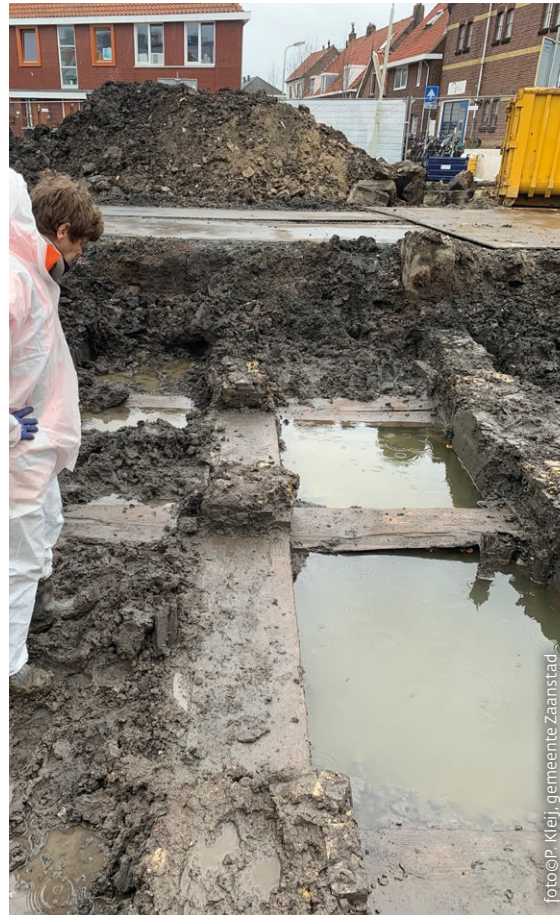
Archeoloog Jan de Koning van Hollandia Archeologen bekijkt het houten raamwerk waarop de poeren van de noorderschuur zijn geplaatst. Daarachter ligt het straatje naar de Zaan. Het ligt ongeveer 40 cm lager dan de tegels van de stoep.
