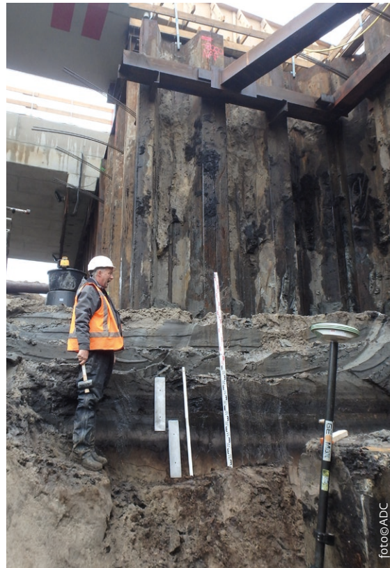
Impressie van de werkzaamheden.
