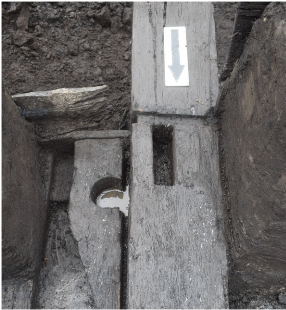
Een van de twee keuspots waar de taats of draaigedeeltes van de sluisdeuren in stonden.
