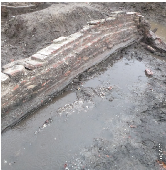
Deel van de bakstenen fundering van de oostelijke lange wand van de kosterswoning.
