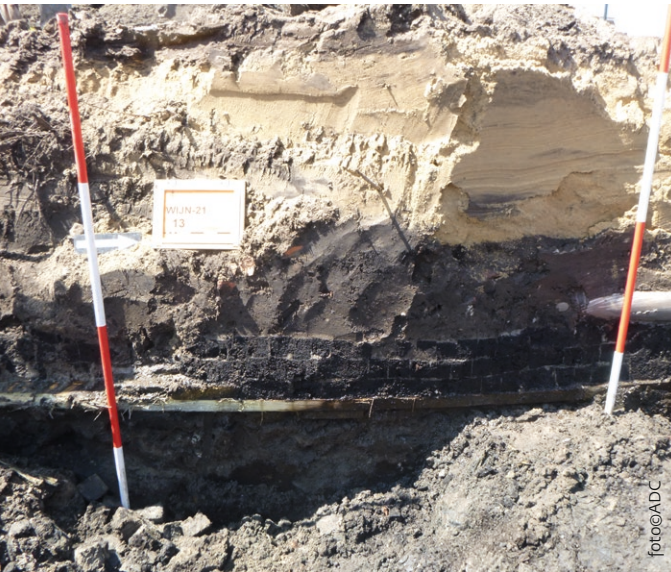
Fundering van gestapelde turfblokken op houten planken.
