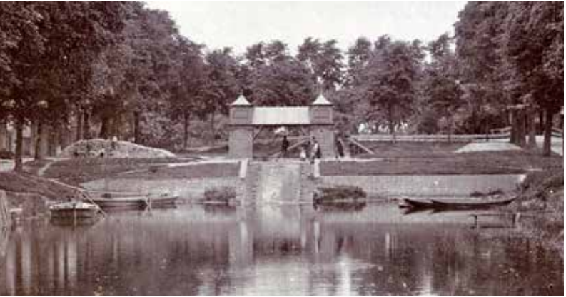
De overtoom aan het begin van de 20ste eeuw. De helling is duidelijk zichtbaar, de raderen zijn niet meer aanwezig.
