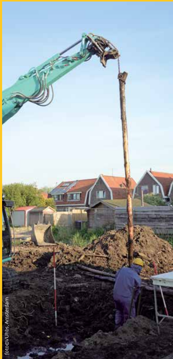
Het trekken van een heipaal voor jaarringdatering op Breedweer 4-10 in Koog aan de Zaan.
