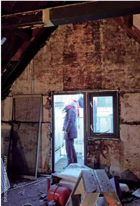
Schouwafdruk tegen de achtergevel van het pand 121-Zuid, circa 1575/1625 (op de verdieping).
