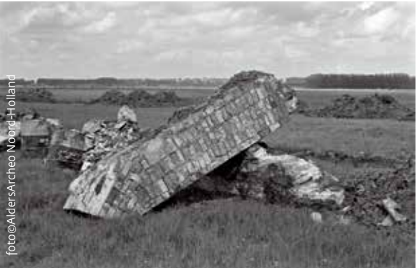
< Leeuwenplaats, uitgesloopte muurbrokken van een brugfundering.
