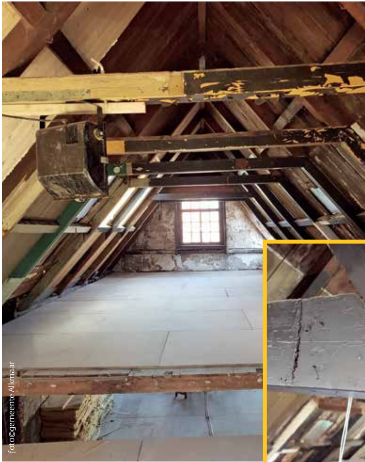
De kap uit 1752 vanuit het zuiden gezien, met verschil in vloerhoogten.
