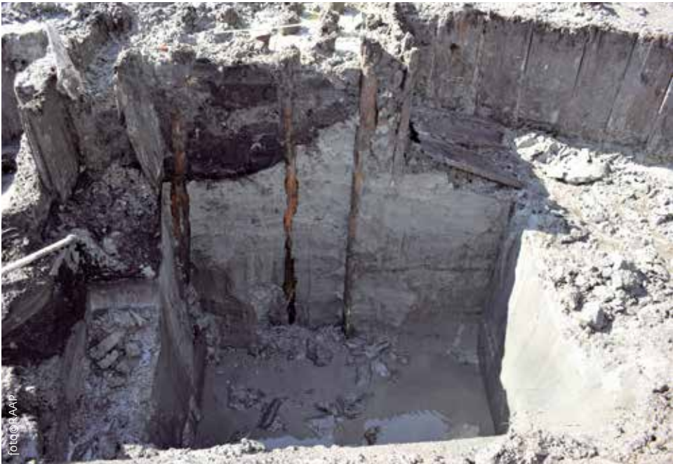
Zijaanzicht van een stiep met 6 m lange heipalen.
