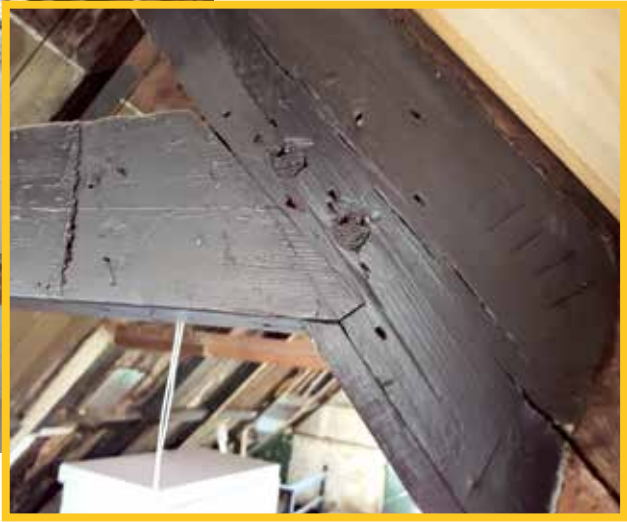
Op een spant en spantbalk in de kap is het telmerk IIIII gekrast. De onderdelen waren eerst op de grond geconstrueerd en gemerkt om ze daarna in de juiste samenstelling te kunnen monteren.
