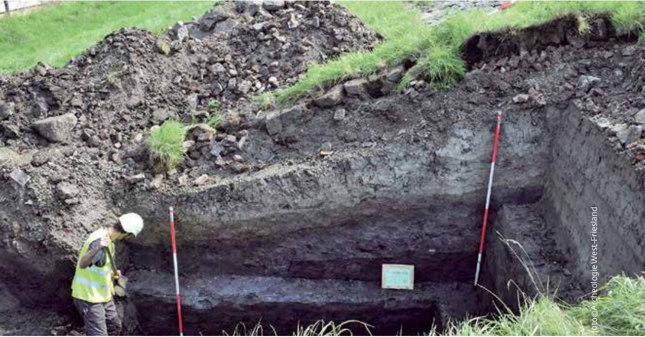
Vindplaats 6.2: buitendijks is de opbouw van de dijk onderzocht en is zicht gekregen op de versterkingen vanaf de 17de eeuw tot aan de moderne tijd.
