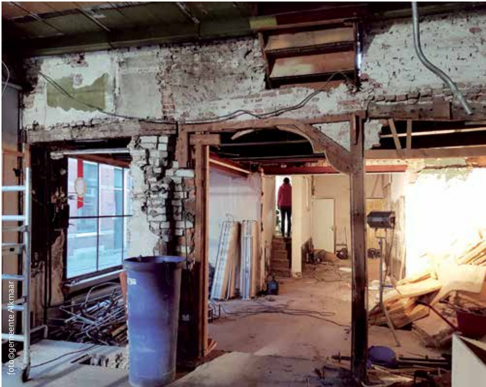
Het interieur van de voormalige winkel, met een merkwaardige houtconstructie die de muur van het tweede huis achter Verdronkenoord 121 opvangt. Boven de doorgang een oude ontlastingsboog in het metselwerk van circa 1600.
