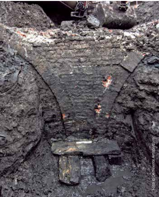
De achterzijde van een centrale rib temidden van twee met klei gevulde gewelven.
