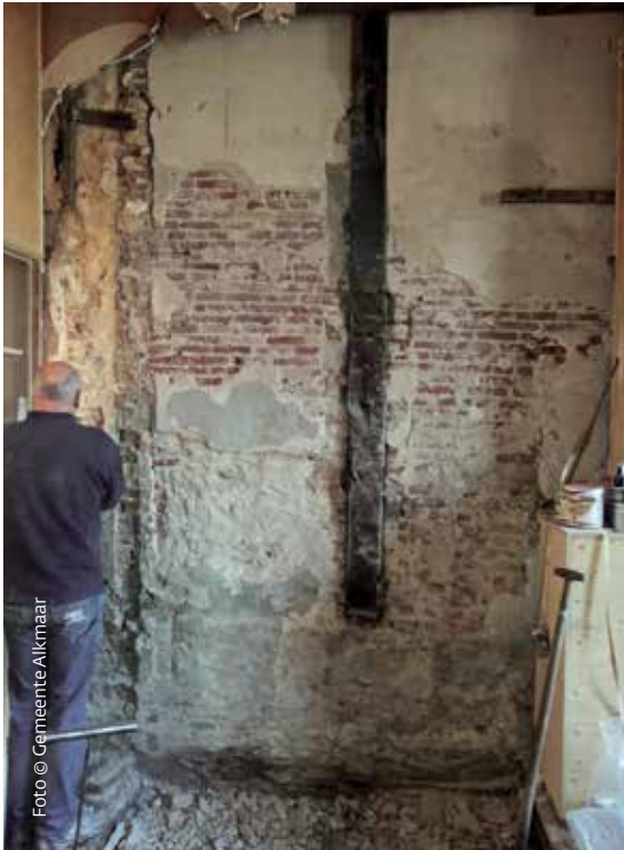
< Detail van de westmuur in de voorkamer, met de in rode steen opgevulde muurnis tussen de muurstijlen.
