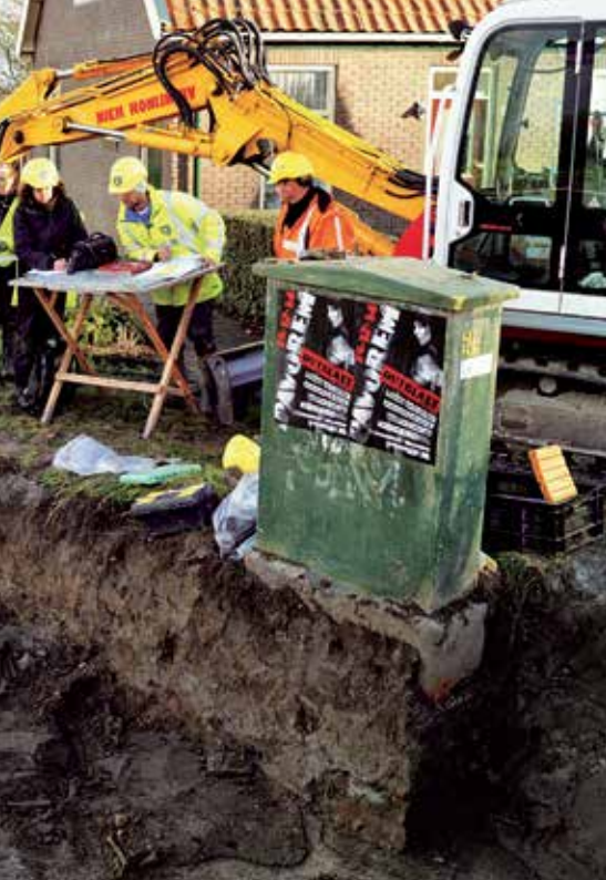
Werk in uitvoering. Binnen een smalle strook langs de huidige brug komen de graven van middeleeuws Almersdorp tevoorschijn.
