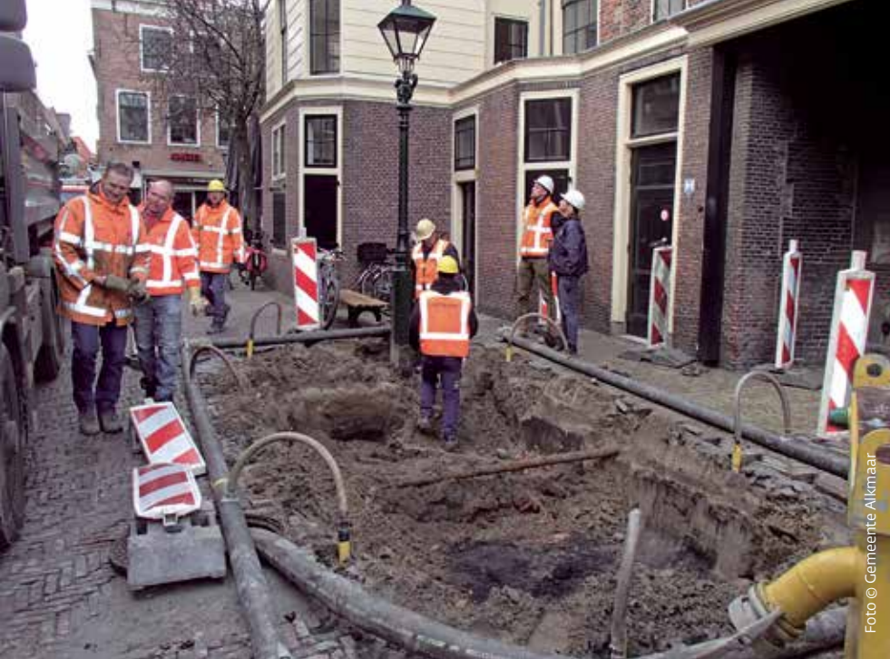
In 2015 komt aan de zuidkant van de Waag op een paar decimeter diepte, precies onder een gasleiding, een huisfundering tevoorschijn. De aanbouw met witte bovenbouw is de onderzoekslocatie van 1997.
