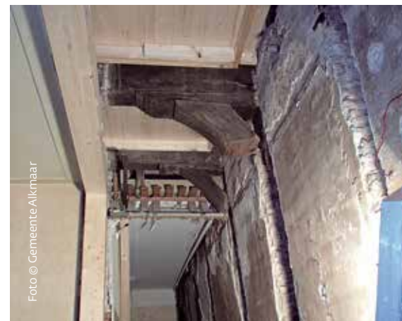
Resten van het houtskelet in de gang bij de oostmuur. De geheel verrotte muurstijlen zijn verwijderd.
