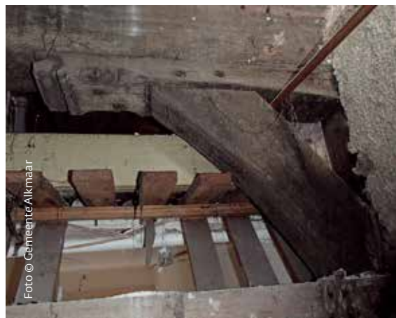
Een gotisch sleutelstuk tussen de balk en het korbeel.
