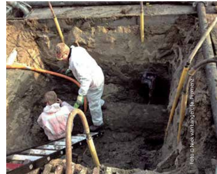
Ontdekking en sloop van het riool uit 1872 tegenover Laat 203.
