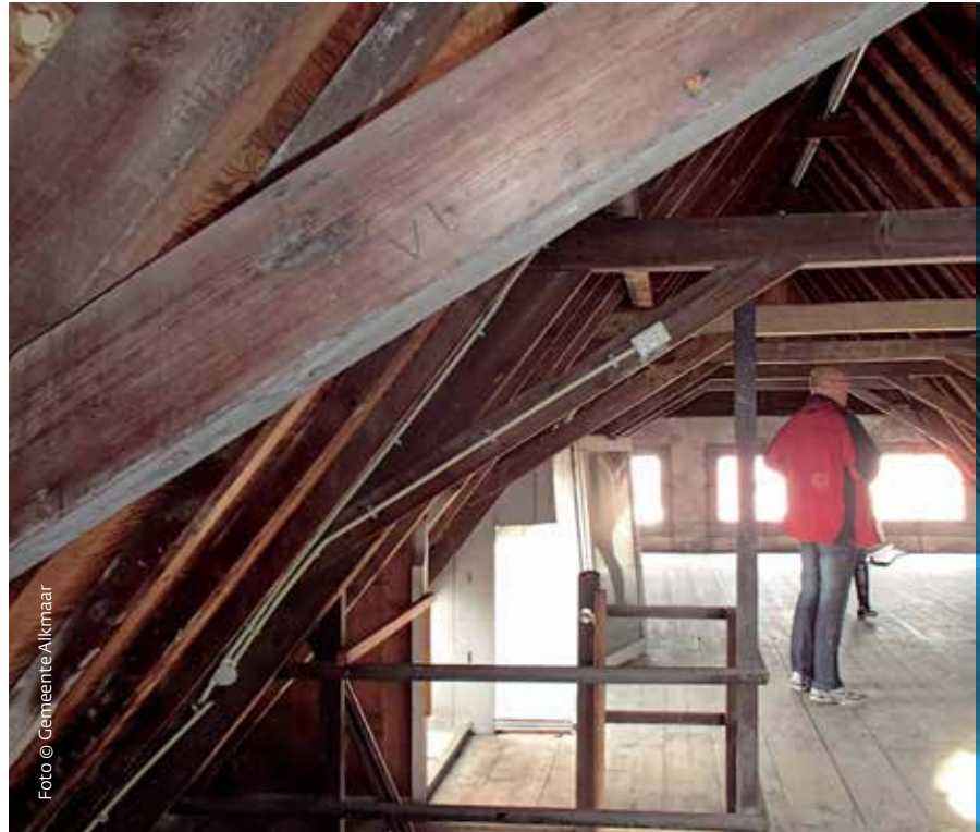
De laat-18de-eeuwse kap met telmerken in Romeinse cijfers is nog geheel intact >
