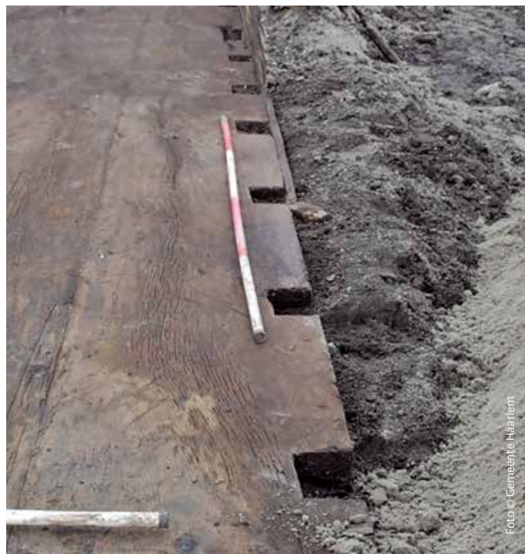
Inkepingen voor de palen van de beschoeiing. >
