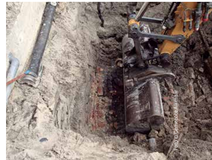
Een fundering (links) en keldertje (rechts) komen in 2014 tevoorschijn in de bouwput voor de container aan de noordkant van het plein. De werkruimte is heel klein.
