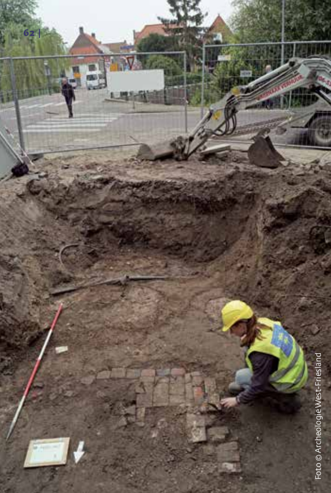
Schoorsteenfundament met stookvloer in het huis dat omstreeks 1648 op het perceel is gebouwd.
