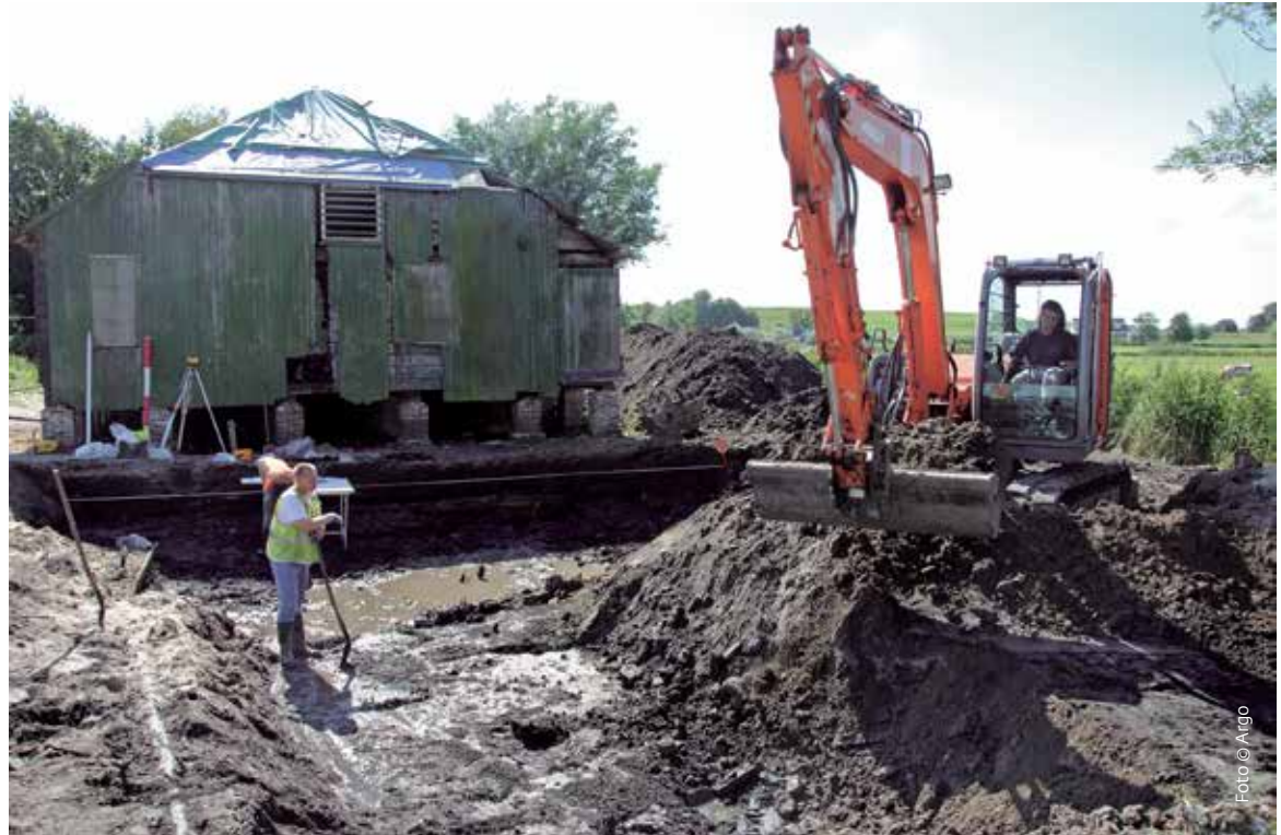
De aanleg van het vlak met op de achtergrond de molenshuur die gerestaureerd gaat worden.
