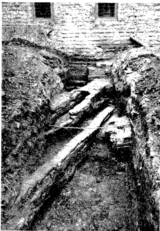
Afb. 7. De opgravingsleuf links van het torenfundament met riolering en veel verstoorde grond. Foto L. Biegestraaten.
