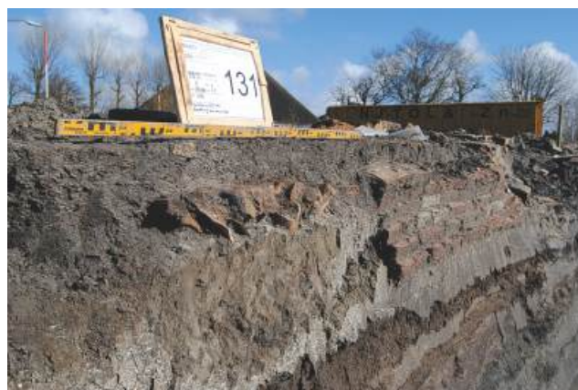
5.86 Boven: de fundering van de zuidelijke zijgevel, met daar haaks op een mogelijke poer om het dak te ondersteunen. Onder: de fundering is aan de flank van de Meerwal getand aangelegd. Daarvoor zijn dierlijke botten zichtbaar. Dit heeft waarschijnlijk gediend als dorpel bij een ingang.
