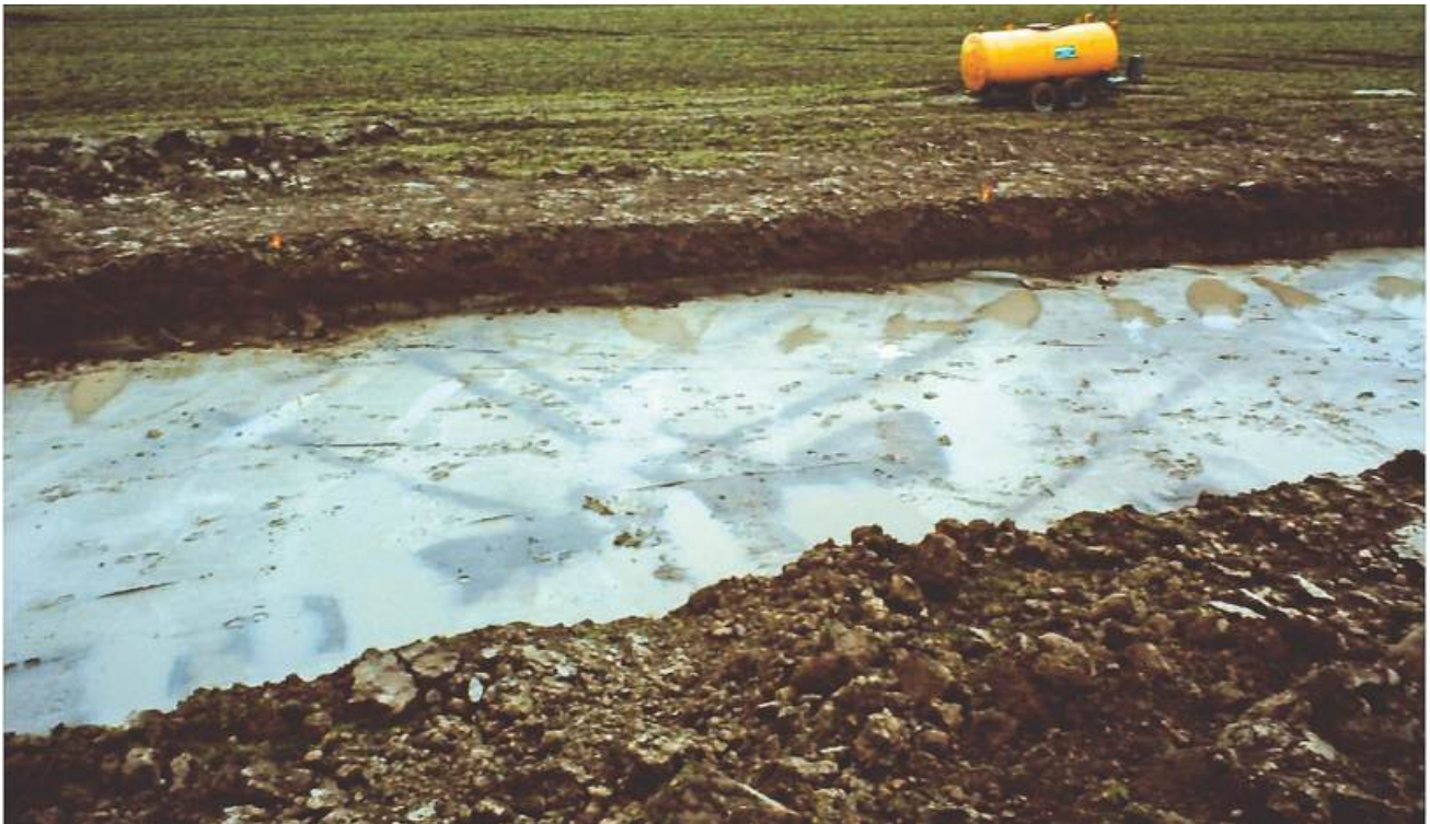
2.13 Witte Paal Noord-Oost (WPV). Helaas werd dit gedeelte van het wegcunet nog dezelfde dag dichtgereden, zodat hier alleen de foto met de greppelstructuren rest.
