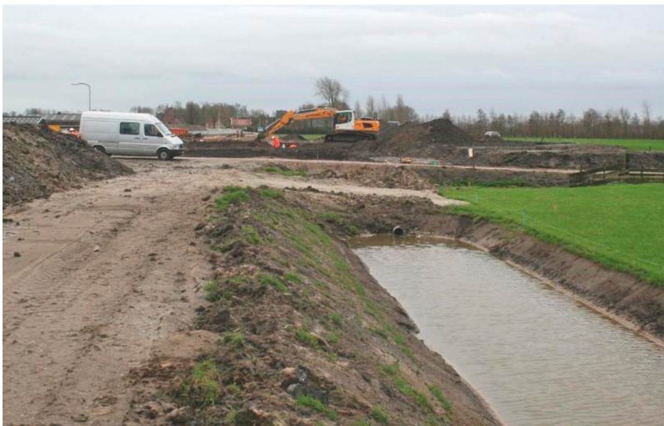
4.9 Overzichtsfoto van de terpopgravingslocatie Zijdedwind. Op de voorgrond de nieuwe slootprofielen (voorgrond rechts) langs het fietspad in aanleg (voorgrond links). Op der achtergrond de werkputten van de opgraving. Achter de grijze bus ligt werkput 3 (WP30, de kraan graaft in werkput 6 (WP60 en direct daarachter ligt werkput 8 (Wp8).
