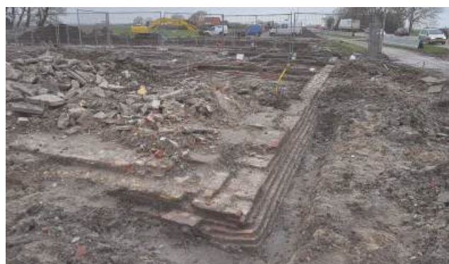
5.122 Foto van de fundering van de buitenmuur van de stolpboerderij. In de fundering zijn bakstenen van de langhuisboerderij hergebruikt.
