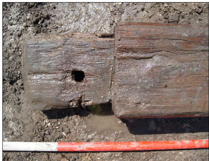
Afb. 5.4.26 M20: de onderkant van de funderingsbalk onder de zuidmuur. Boven een detail van een houtverbinding.
