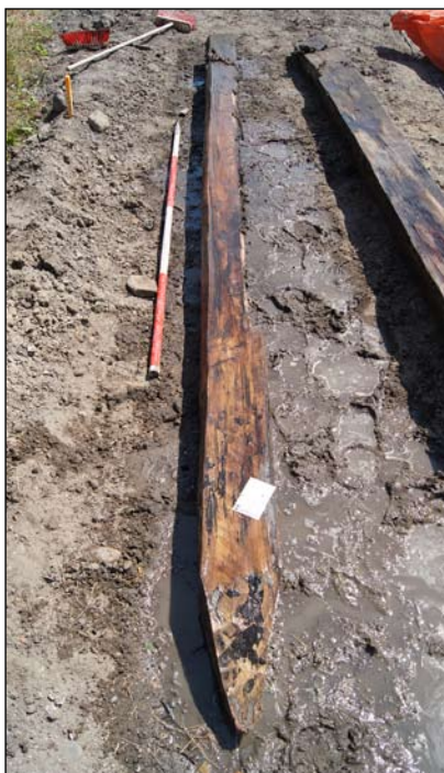
Afb. 5.4.27 M23: Een funderingspaal onder de balken. Boven een detail van een pen-gat-verbinding op een paal in situ.
