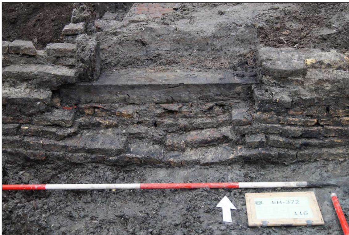
Afb. 5.9.5 Dorpel S175 in de oostzijde van de achtergevel, gezien richting het noorden.
