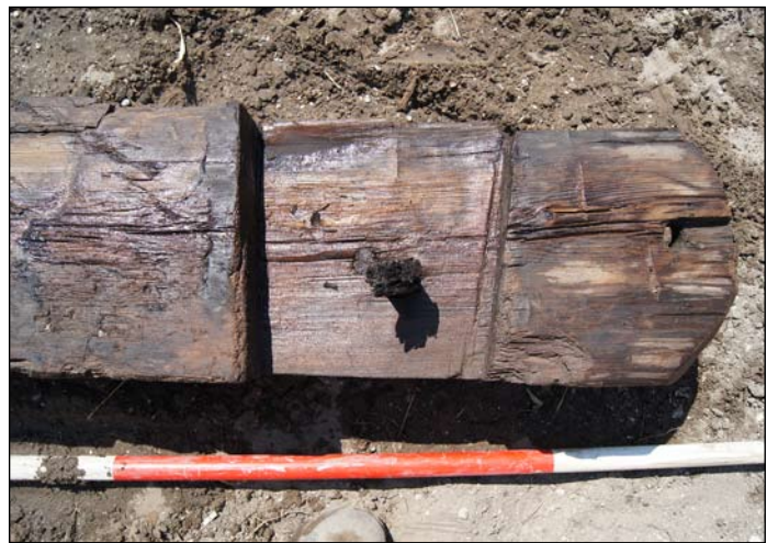
Afb. 5.4.24 M21: de bovenkant van de funderingsbalk onder de oostmuur van de kelder. Boven een detail van een houtverbinding met toognagel.
