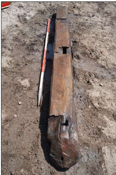
Afb. 5.4.25 M21: de onderkant van de funderingsbalk onder de oostmuur van de kelder. Boven een detail van een pen-gat-verbinding waarmee de balk met een funderingspaal was verbonden.
