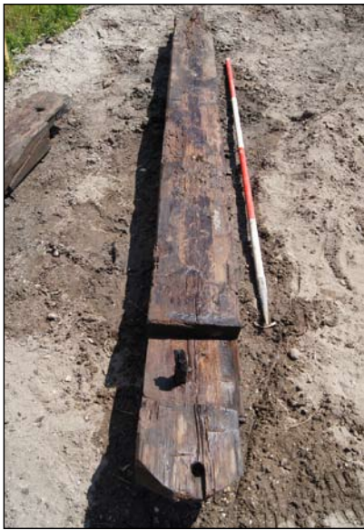
Afb. 5.4.24 M21: de bovenkant van de funderingsbalk onder de oostmuur van de kelder. Boven een detail van een houtverbinding met toognagel.
