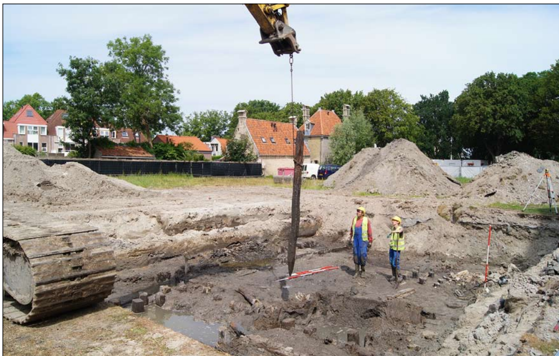
Afb. 3.3 Een funderingspaal wordt getrokken ten behoeve van dendrochronologisch onderzoek.
