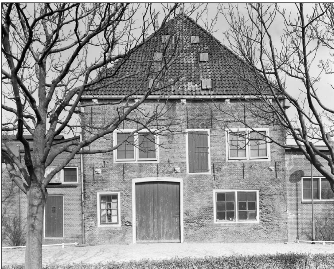
Afb. 2.14 De zuidgevel van het pakhuys in 1969. Collectie Rijksdienst voor het Cultureel Erfgoed.
