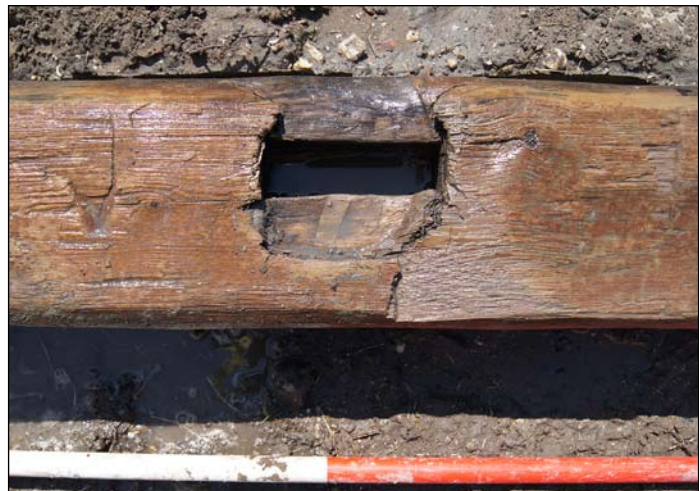
Afb. 5.4.25 M21: de onderkant van de funderingsbalk onder de oostmuur van de kelder. Boven een detail van een pen-gat-verbinding waarmee de balk met een funderingspaal was verbonden.
