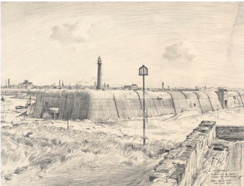
← Duikbotenbunker, IJmuiden, Chris Schut (1951) inv.nr. 359-6050 (beeldcollectie Provinciale Atlas Noord-Holland).
