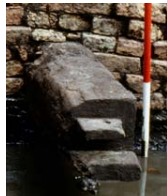
Balk met bouwsporen, opnieuw gebruikt in de fundering van het muurwerk
