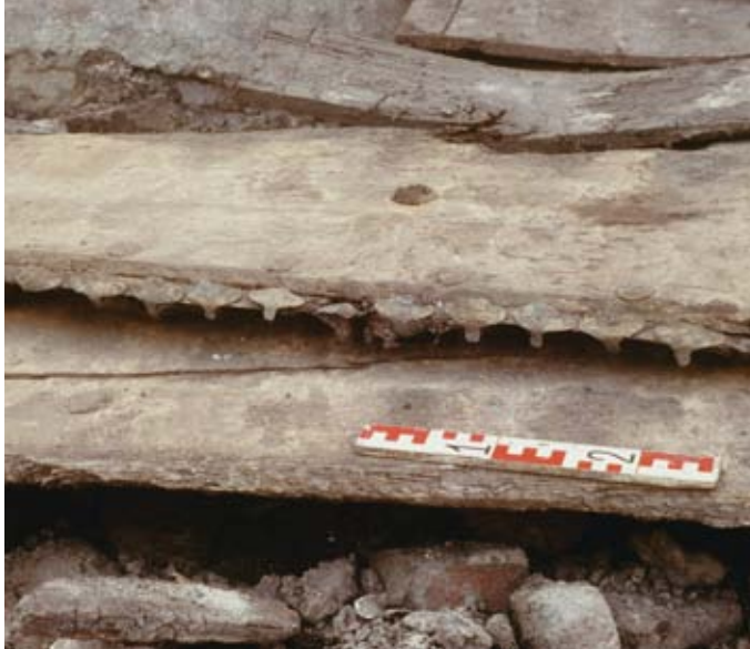
Enkele scheepsdelen met een rij ijzereen scheepssintels uit de fundering van de veertiende-eeuwse verlenging van het huis Warmoesstraat 105
