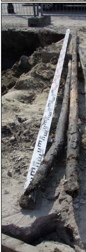
Afb. 13: Aangepunte onderzijde van de slieten (boven).
