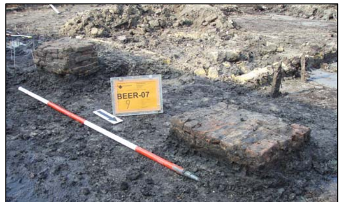
Afb. 19 en 20: De twee basementen van gebouw 2. Het noordelijke is op hout gefundeerd.
