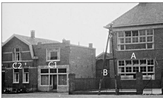
Afb. 23: Foto uit de jaren '20 van de 20e eeuw (ca. 1926) waarop gebouw A t/m C zichtbaar zijn.
