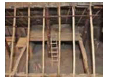
fig. 5.15 Impressie van het woongedeelte (rechts) en het stalgedeelte (boven) van het tweebeukige woonstalhuis 3 uit Bloemendaal-Groot Olmen. De kasporen zijn tegen de nokgording aangebracht, terwijl de onderkant van de kasporen bevestigd zijn aan een wandplaat. Deze wandplaat zorgt voor het langsverband in de stevig uitgevoerde wand. De zolder strekte zich oorspronkelijk wellicht over de volledige stal uit (maquette J. Matser, tentoongesteld in Archeologiemuseum Huis van Hilde; foto J. de Koning).
