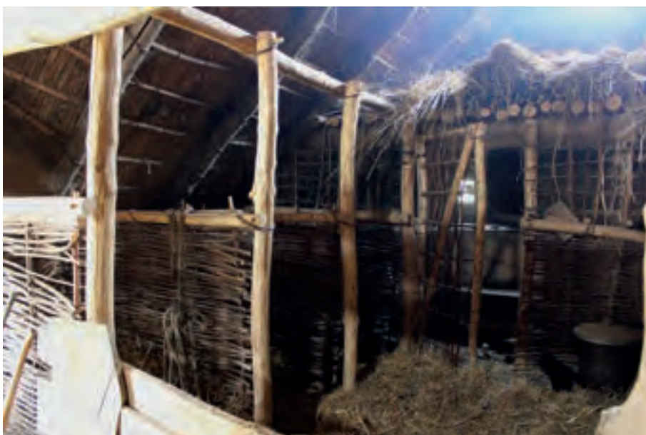
fig. 5.4 Voorbeeld van stalboxen in een gereconstrueerde vroegmiddeleeuwse boerderij in archeologisch openluchtmuseum Erve Eme, Zutphen. Gekozen is voor relatief smalle, ‘enkele’ boxen, waarvan de stevigheid is vergroot door een erboven aangebrachte horizontale verbinding. Een deel van de stal is voorzien van een zoldervloer, bestaande uit rondhouten tasliggers op een dwarsligger. Hierop is hooi opgeslagen (foto M. Dijkstra).
