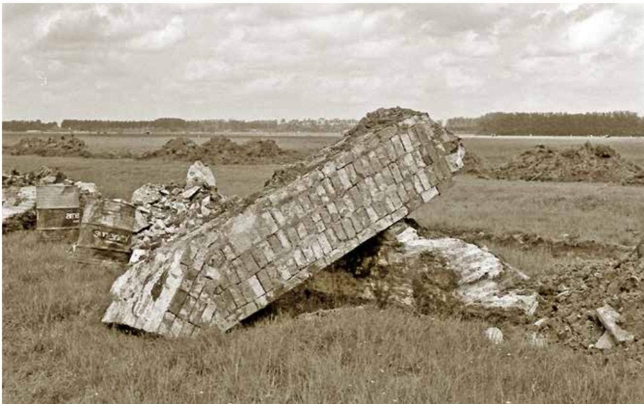
Afbeelding 16 Losse brokken muurwerk van brug (S19) tussen middenlaan en hoofdeiland (opname: H.Tol).
