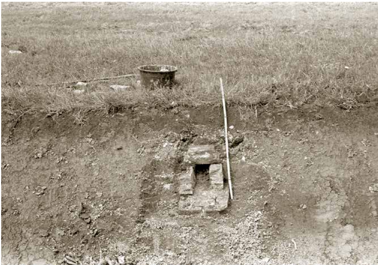
Afbeelding 4 Rioolpijp (S1) in oever van de nieuwe kavelsloot, vanuit oosten (opname: H.Tol).
