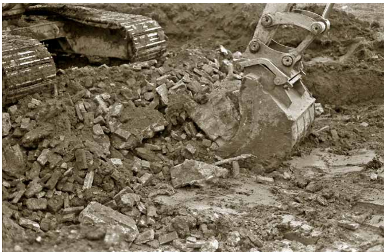
Afbeelding 2 Graafwerkzaamheden tijdens het egaliseren van het terrein (opname: H.Tol).
