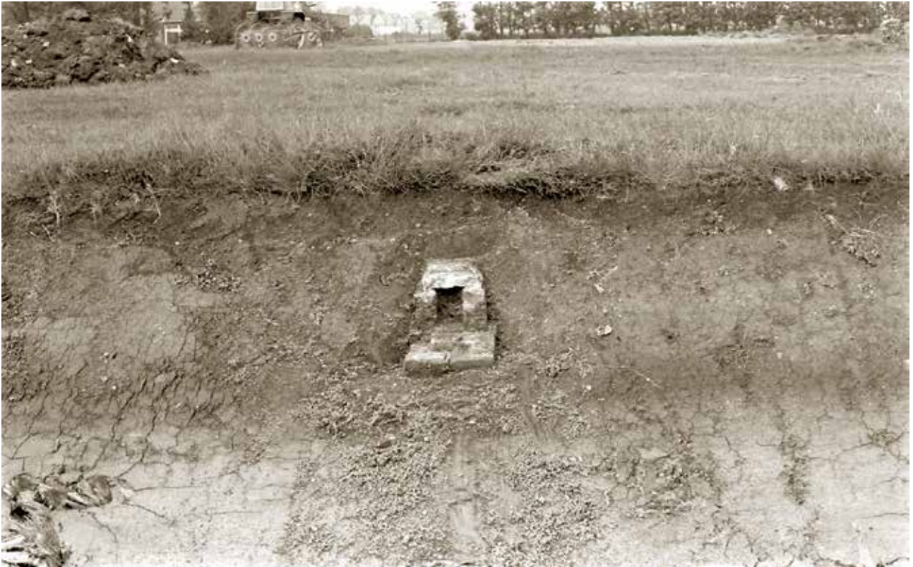
Afbeelding 6 Rioolpijp (S3) in oever van de nieuwe kavelsloot, vanuit oosten (opname: H.Tol).
