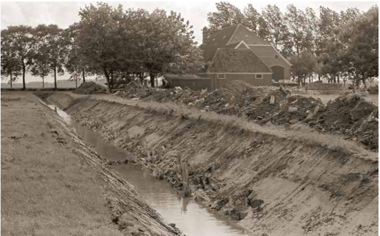
Afbeelding 15 Nieuw gegraven kavelsloot met resten van de funderingspalen van tuinmuur (S6) en op de achtergrond de huidige boerderij, vanuit noordoosten (opname: H.Tol).
