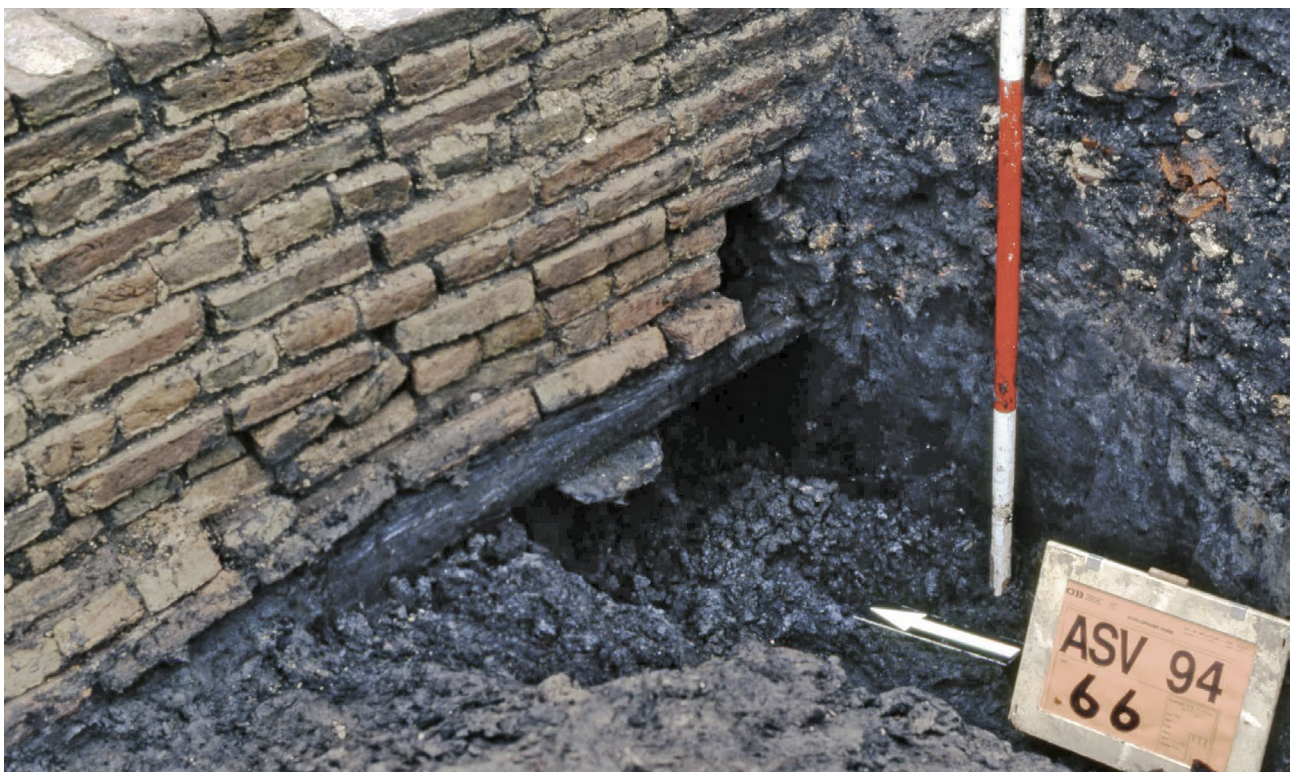
Afbeelding 12 Detail van het midden van fundering S1 (WP4) waaronder het liggende funderingshout zichtbaar is. Rechts bevindt zich het ingetekende profiel.
