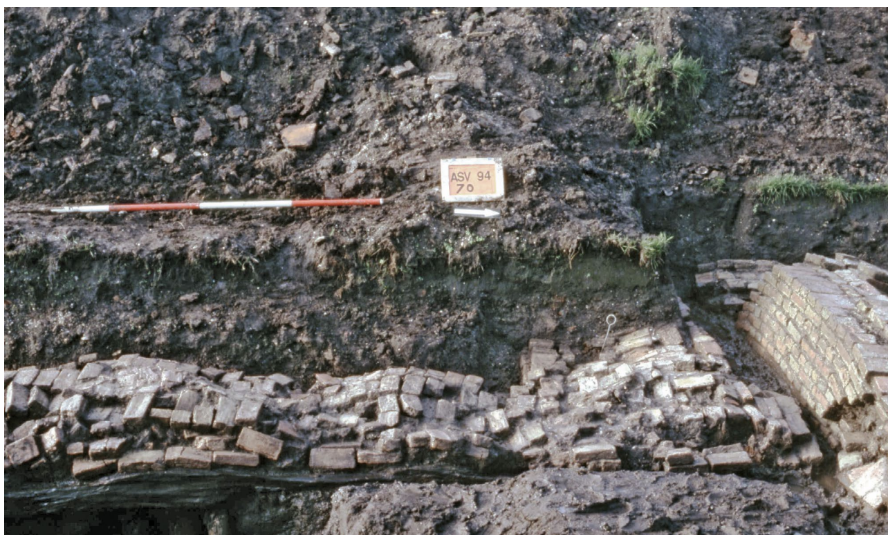
Afbeelding 14 Fundering S2 (WP4) uit de tweede bouwfase vanuit het oosten. Onder de fundering zijn nog juist het liggend funderingshout en de elzen slieten te zien. Rechts ligt torenmuur S1 uit de eerste bouwfase.
