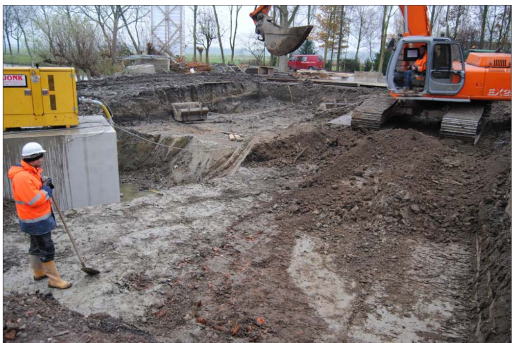
Afbeelding 11. Momentopname van de aanleg van werkput 4.
