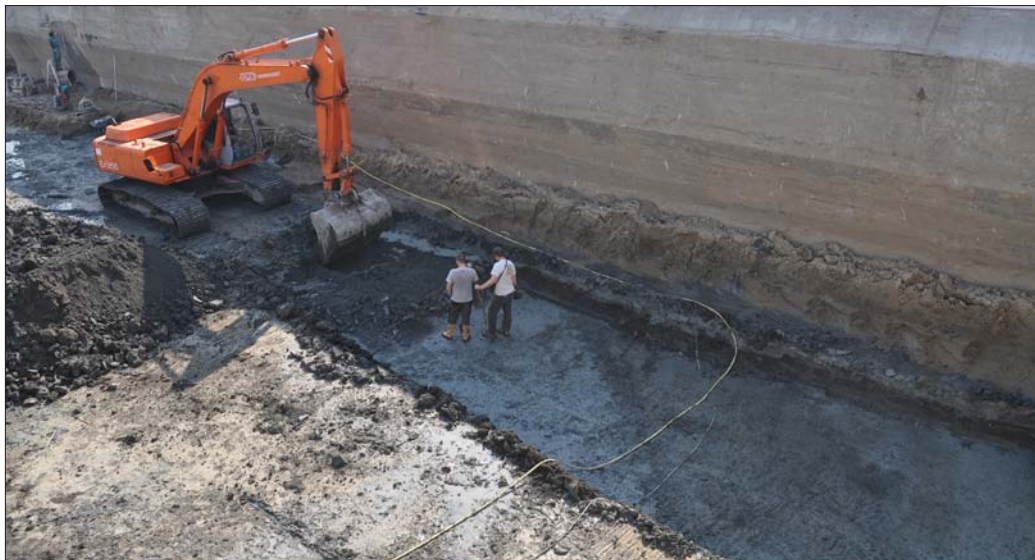
Afbeelding 9. Momentopname van de aanleg van werkput 1.
