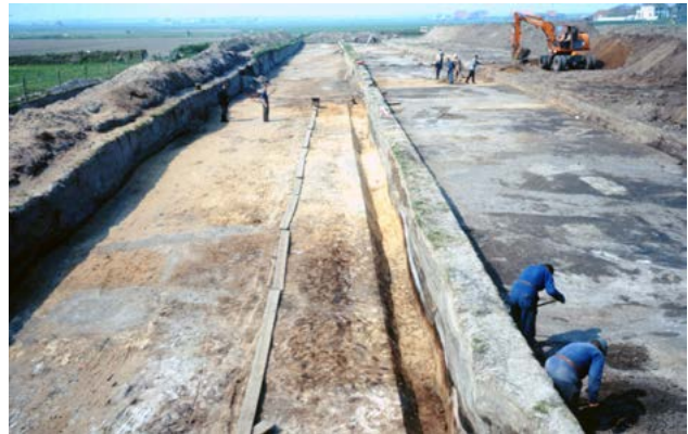
Afb. 1.2 Opgravingsputten 2 en 3 tijdens het onderzoek in 1967, gezien vanuit het zuiden.
