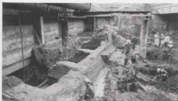
Afb. 14. Rotterdam: tracé Willemsspoortunnel. Opgraving stadsmuur met fragment van ronde toren langs de Blaak. Foto BOOR.
