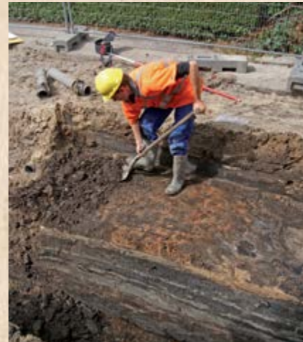
Aan de Kalksteiger hoek Breedstraat in Enkhuizen kwamen grote oranje vlekken van een haardplaats tevoorschijn. Deze behoorde bij een huis dat rond 1200 op de Westfriesse Omringdijk stond.
