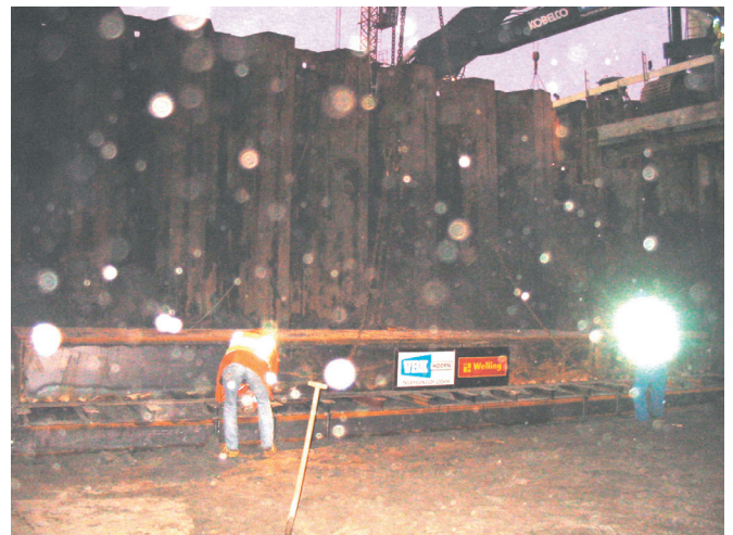
Figuur 37 De kettingen zijn bevestigd aan de kraan
