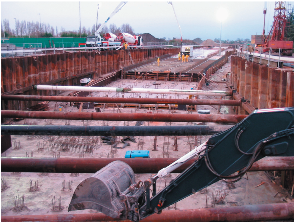
Figuur 4 Blik in zuidelijke richting vanaf de kano-locatie over het tunneltracé.
