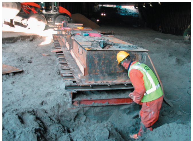
Figuur 35 De tien ton wegende stalen kist moest vervolgens in de juiste positie geschoven worden om uit het kleine gat gehezen te worden.
