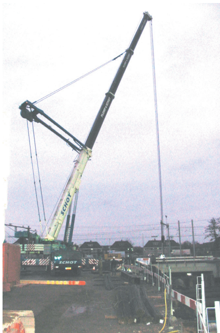
Figuur 38 Een enorme telekraan had geen moeite met het tien ton wegende gevaarte.
