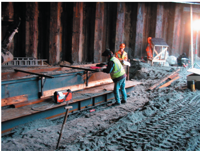
Figuur 34 Nadat de bekisting aan elkaar werd gelast, werd op de kano grond gestort en het geheel vervolgens afgedekt met een deksel.
