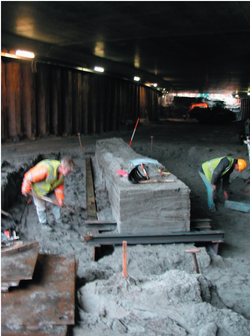
Figuur 32 Onder de kano werden gaten geboord waarin stalen balken geplaatst konden worden.
