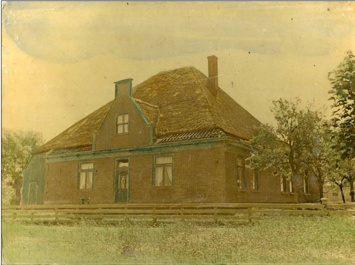
Afb. 36 De oudste (ingekleurde) foto van de boerderij, genomen na de verbouwing van de jaren 20 waarbij de houten wanden zijn vervangen door bakstenen muren. Foto familie Zwaan.
