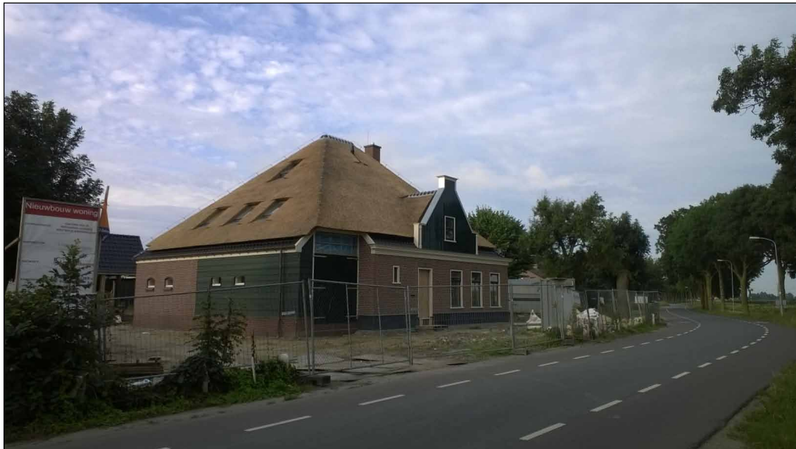
Afb. 100 De herbouw van Binnenwijzend 100 is in augustus 2014 in volle gang.
