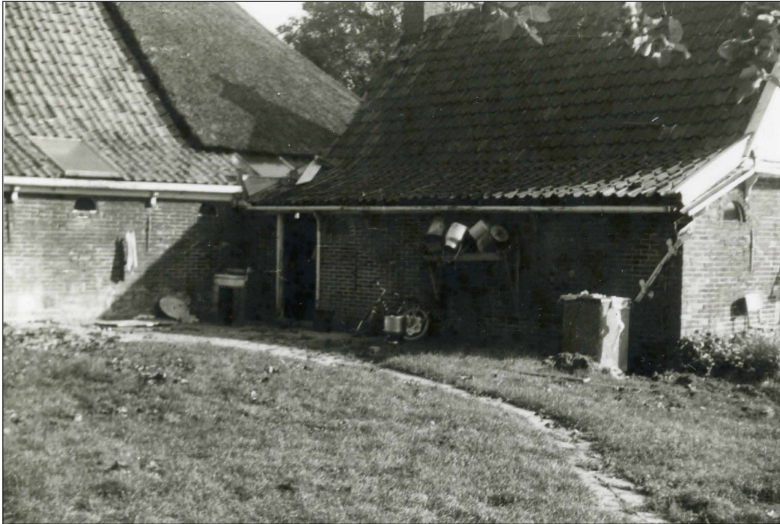
Afb. 44 De westzijde van de boet. Aan de rechterkant de opbouw van een waterkelder, links daarvan het melkbussenrek. Foto familie Zwaan.
