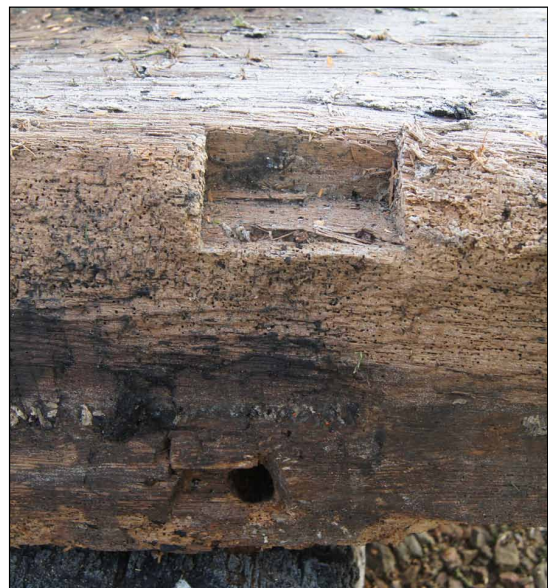
Afb. 55 Een schuin gat op de hoek van een vierkantstijl, waarschijnlijk een vlotgat.
