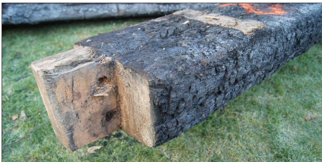
Afb. 49 De rechthoekige pen aan de bovenzijde van een vierkantstijl.
