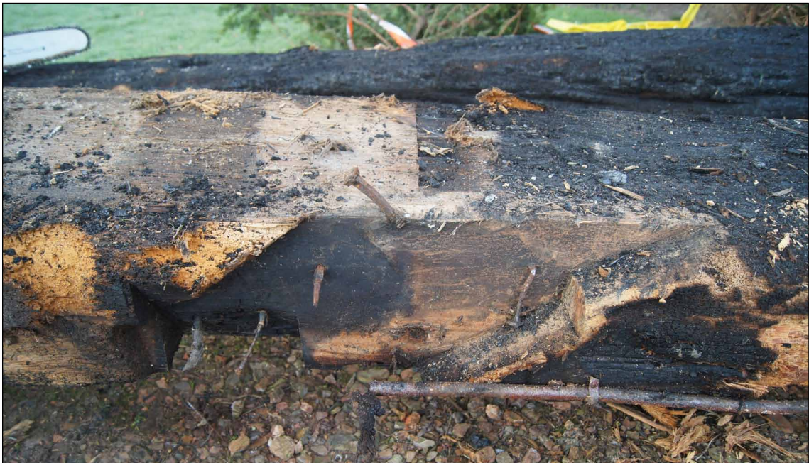
Afb. 53 Een schuine inkeping met hak voor een zwing. Linksonder is bovendien een schuine inkeping aanwezig van een tilbalk.
