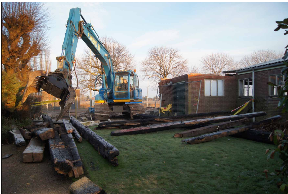
Afb. 60 De balken van het vierkant worden bij de sloop apart gelegd voor nader onderzoek.
