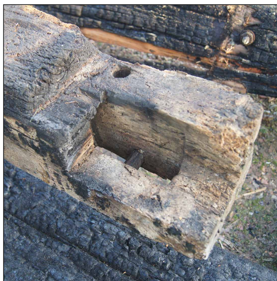
Afb. 57 Een rechthoekig gat met toognagels van een pen-en-gatverbinding in een secundair gebruikte eiken balk.
