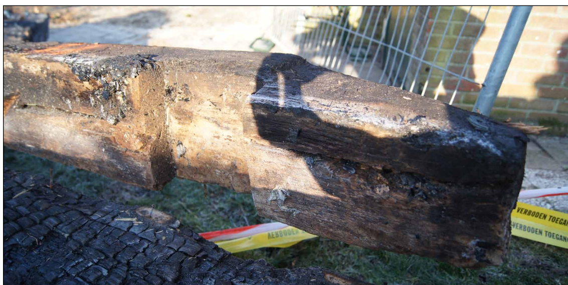
Afb. 56 Een rechthoekige inkeping met toognagels in een secundair gebruikte eiken balk.
