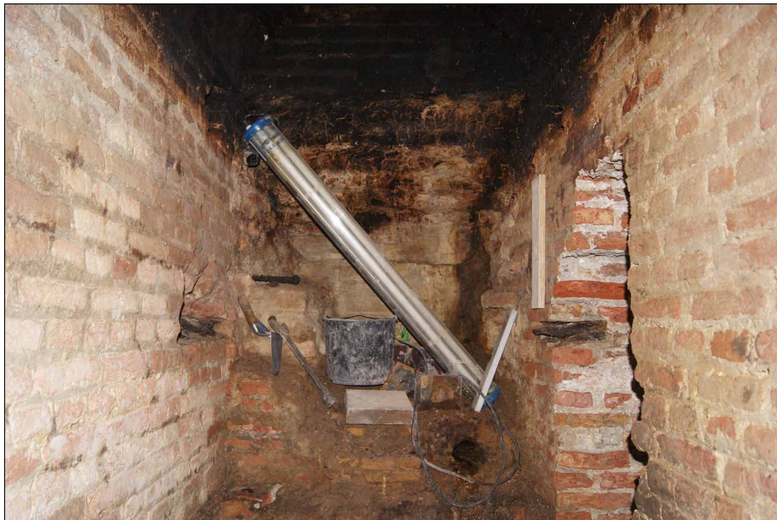
Afb. 55 De binnenzijde van gevangenis 1. Aan de achterzijde zijn blokken natuursteen zichtbaar. Aan de onderkant bevindt zich rechts een holle houten buis. Aan weerszijden zijn de restanten van een houten plank zichtbaar in de muur. Het gat in de rechtermuur dateert van de verbouwing.
