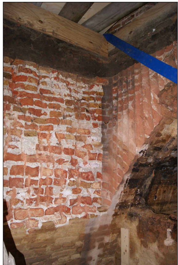
Afb. 37 Dwarsdoorsnede van het tongewelf van de geschutskelder. Op het bakstenen gewelf ligt een laag grond.
