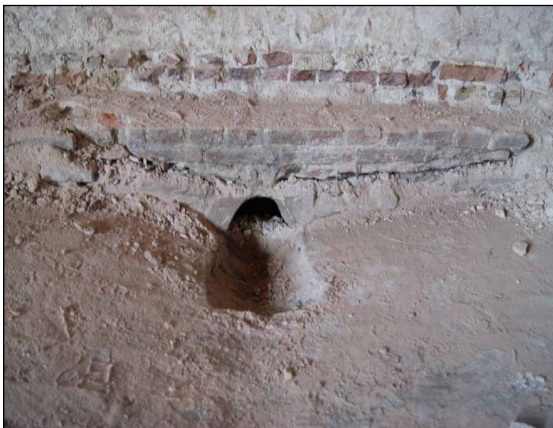
Afb. 14 Een van de goten door de buitenmuur van het rondeel voor de afvoer van regenwater vanaf het dak.
