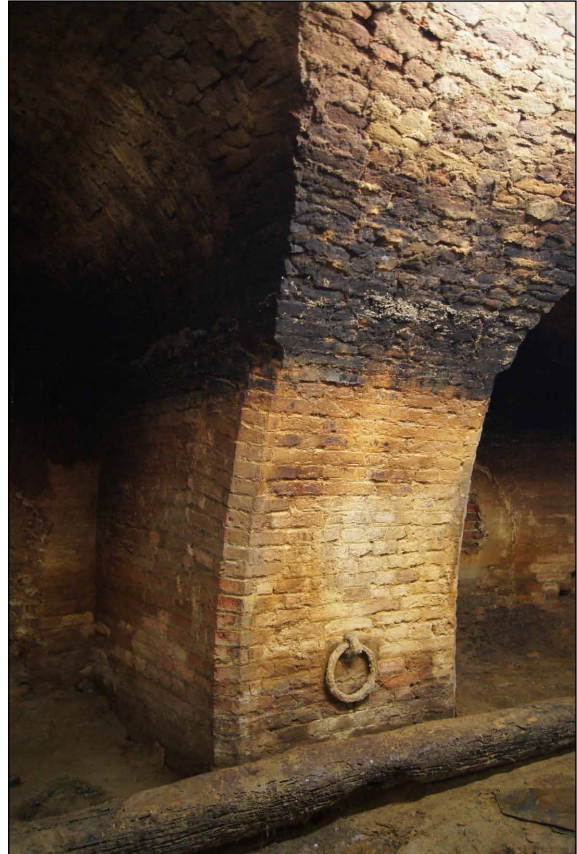
Afb. 45 Een ijzeren ring in de muur tussen geschutsnis 3 en 4.
