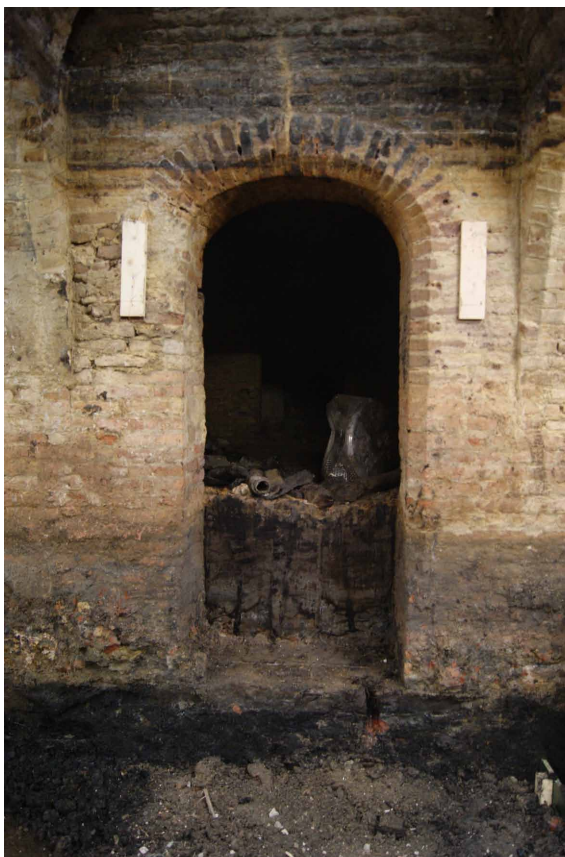
Afb. 80 De deuropening van gevangenis 3 na het uitgraven van de kelder.
