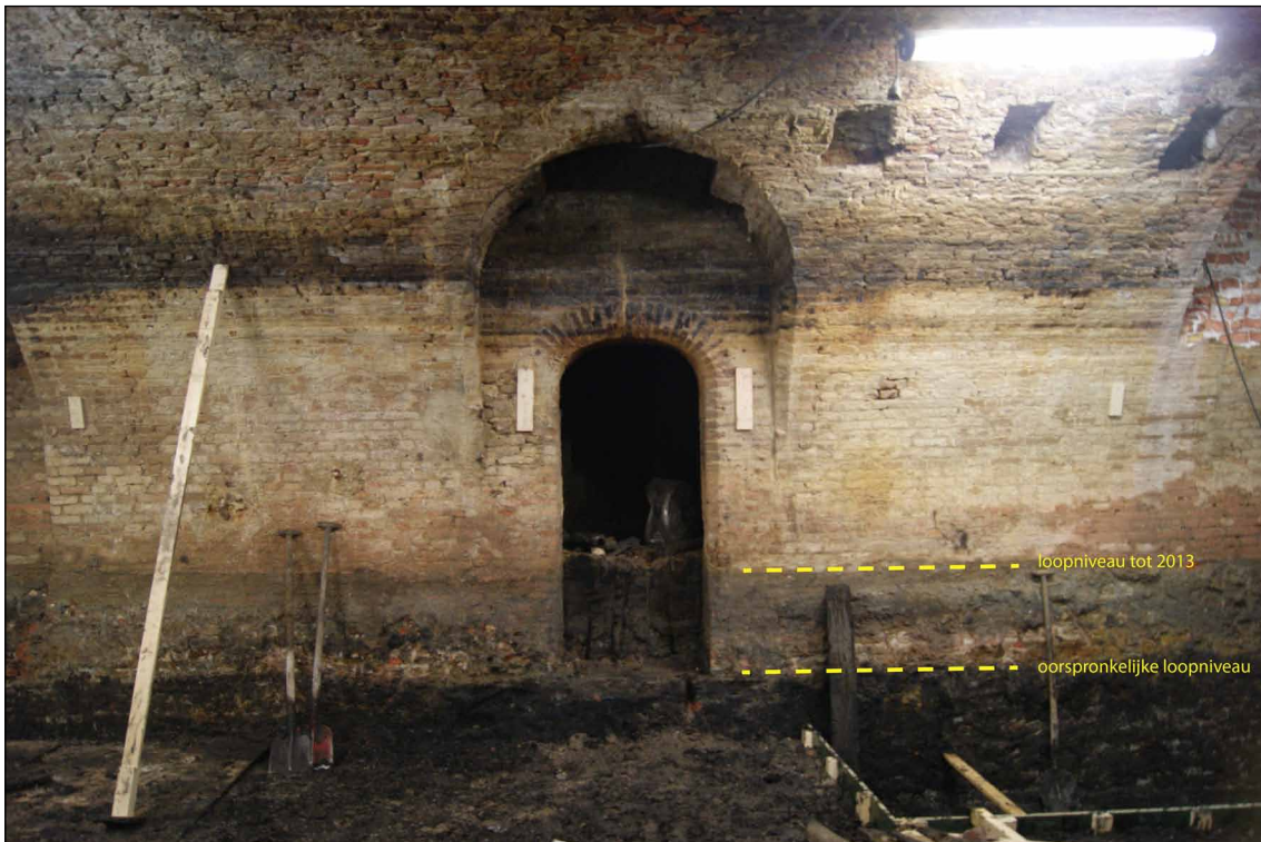
Afb. 68 De bodemopbouw is af te lezen van de rechte muur in de geschutskelder.
