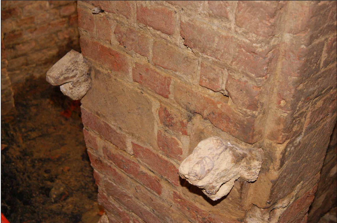
Afb. 49 De klinkneus van gevangenis 1 en de deuropening naar de trap.
