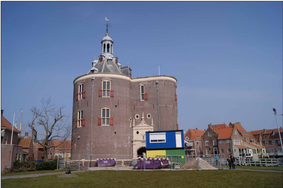
Afb. 94 De Drommedaris tijdens de restauratie.
