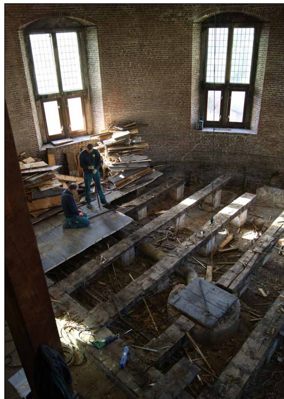
Afb. 19 De houten vloer uit 1649 op het bakstenen dak van het grote rondel wordt verwijderd, februari 2013.
