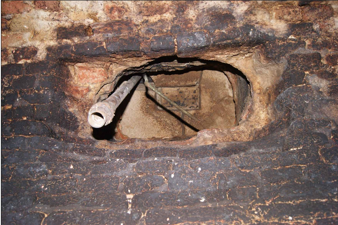
Afb. 56 Een gat in het plafond van gevangenis 1.
