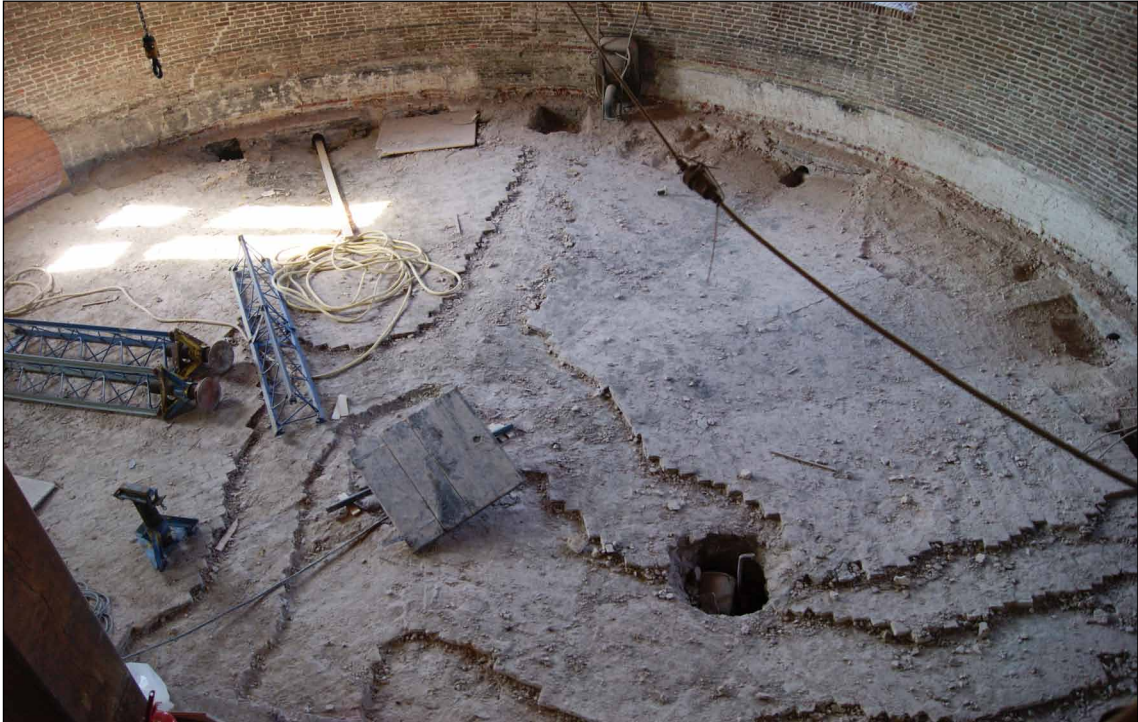
Afb. 13 Het oorspronkelijke bakstenen dak van het grote rondeel is weer zichtbaar na het verwijderen van een houten vloer. Foto genomen tijdens de restauratie.
