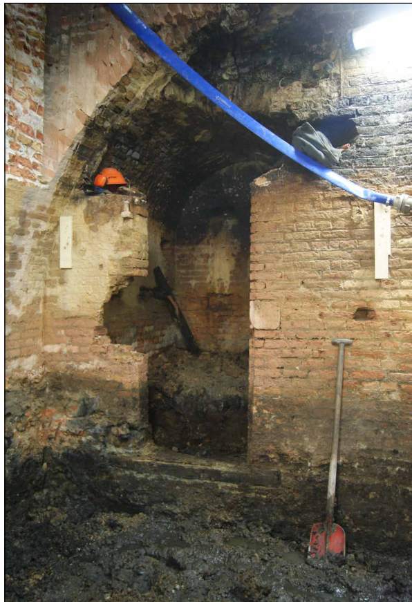
Afb. 77 De deuropening van gevangenis 2 na het uitgraven van de kelder.
