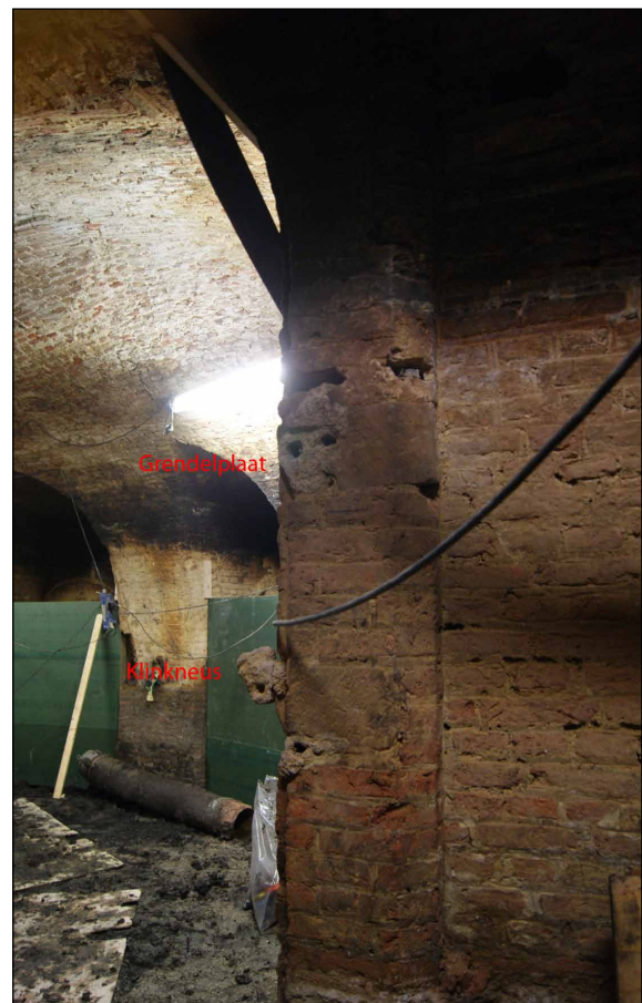
Afb. 50 De grendelplaat en klinkneus van de deuropening naar de trap, gezien vanuit het trappgat.
