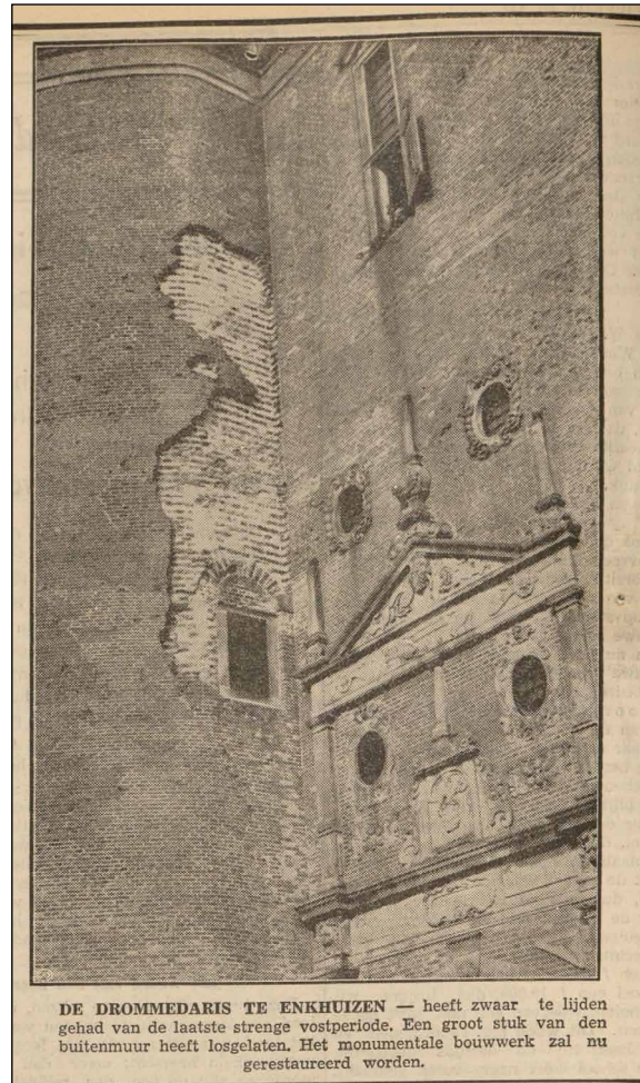
Afb. 25 Een krantenbericht uit de Alkmaarsche Courant van 16 februari 1939. Op de foto is zichtbaar dat de muren van het gebouw bestaan uit een buitenste en een binnenste schil.
