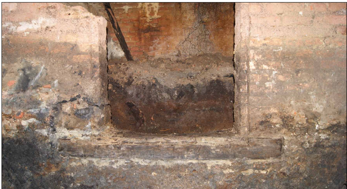
Afb. 79 Detail van de dorpel van gevangenis 2 en de bodemopbouw in de ruimte.
