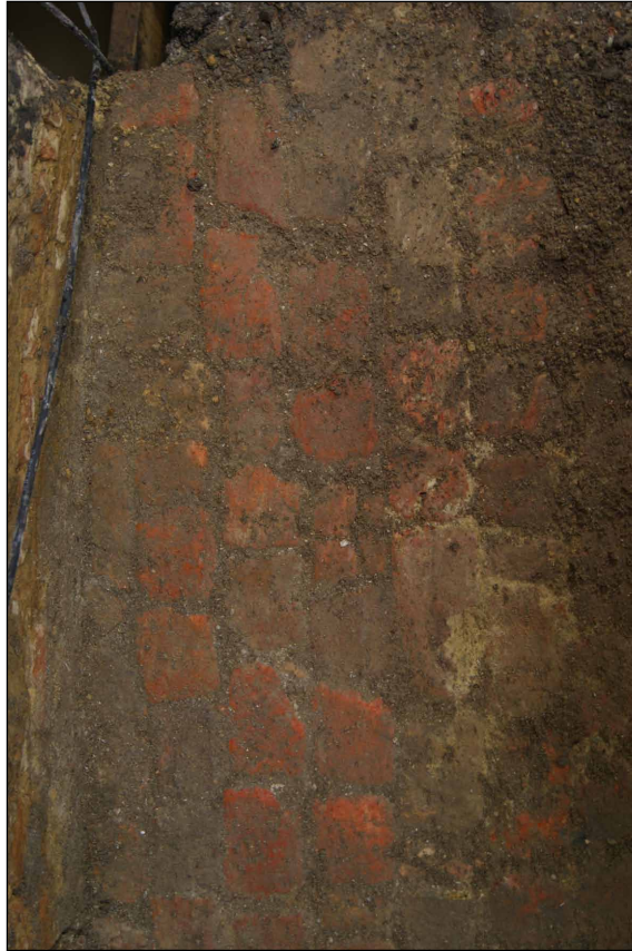
Afb. 67 Detail van de bakstenen vloer.
