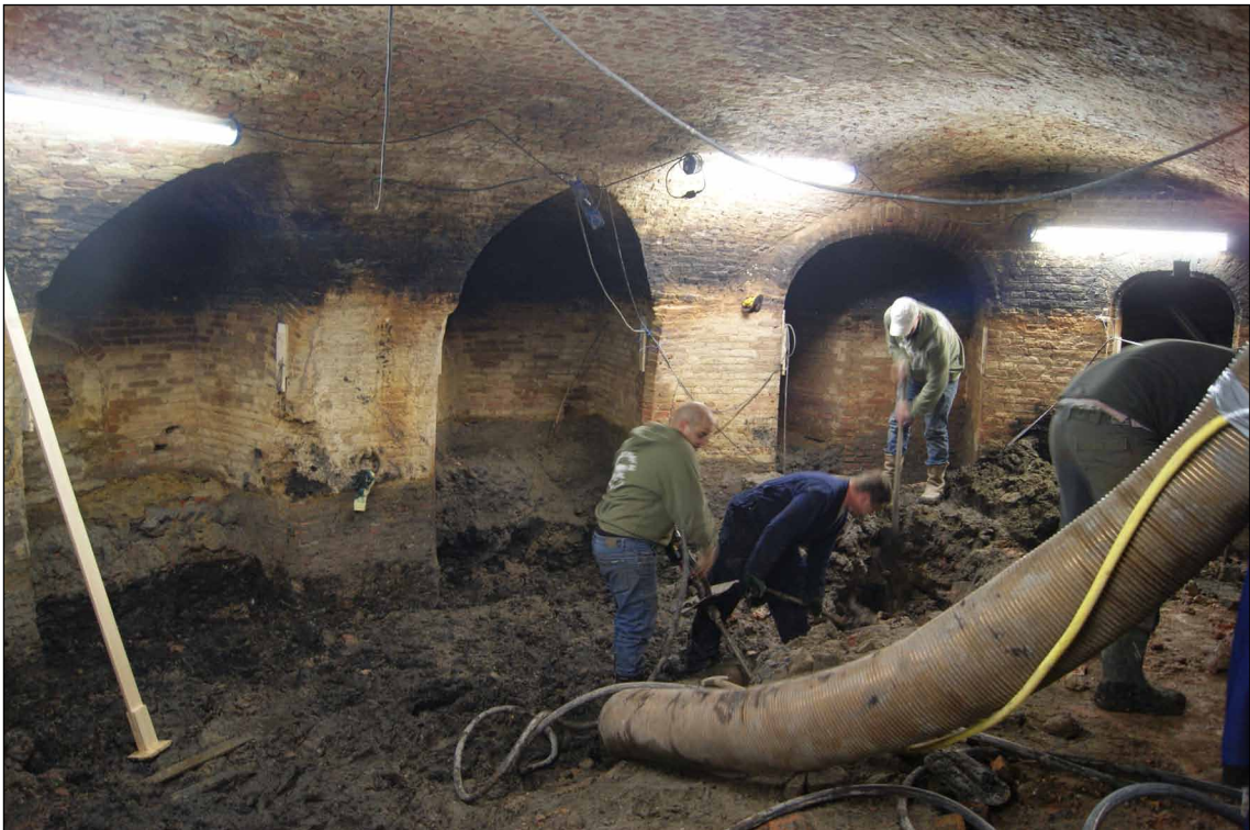
Afb. 27 De grond in de geschutskamer wordt losgemaakt en weggezogen.
