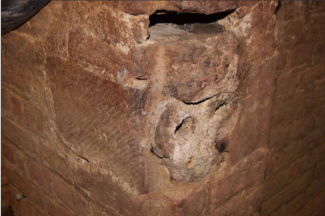
Afb. 51 De grendelplaat van de deuropening naar de trap.
