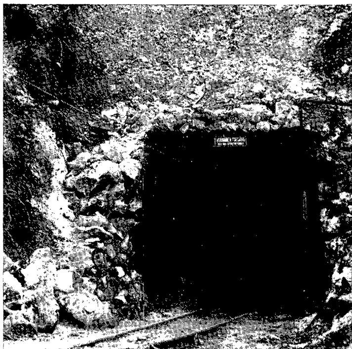
Fig. 4: Ingang van de tunnel, voordat de transportband-installatie geplaatst was.
