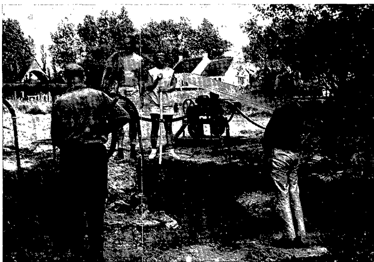
Fif. 17. Bij de pompinstallatie op werf B1. (Foto mevr. W. de Groot-Kerkhoven).
